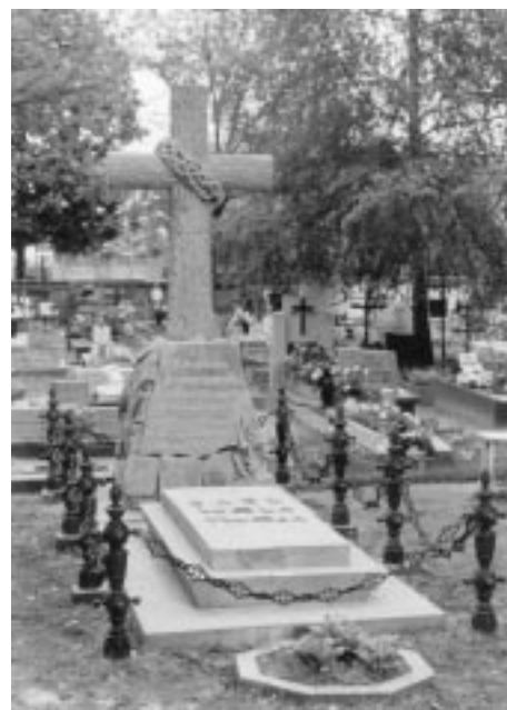
Grobowiec śp. ks. A. Szamarzewskiego. Po renowacji wykonanej przez firmę Jana Chojckiego, maj 2001 r.
